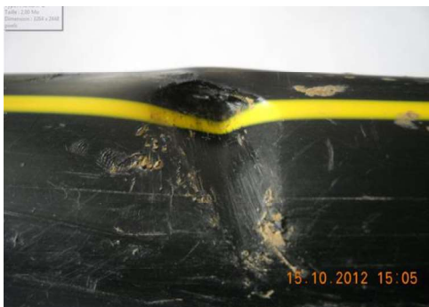
barre à mine / canalisation PEHD gaz MPB
