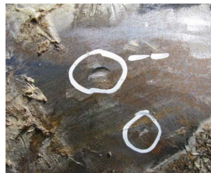
pioche / canalisation acier gaz HP
