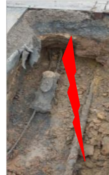
Dégagement à la pelle au voisinage de câble type papier imprégné sous tension.
