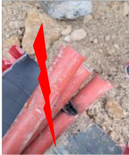
Utilisation d'une scie pour découper un fourreau qui contient un câble HTA.
